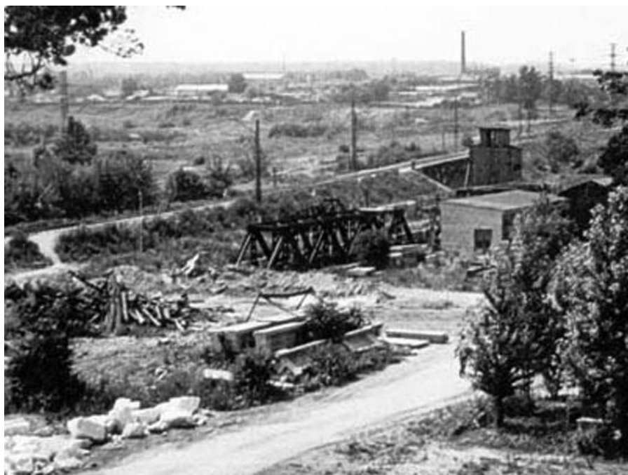
Фрагмент фотографии конца 1960-х — начала 70-х годов с сайта «Отрадное глазами его жителя». Мост, который защищала 21-я батарея, на этом снимке находится в центре. Здесь он уже демонтирован, а через Язузу перекинут новый. http://otradnoe.by.ru/index.htm
